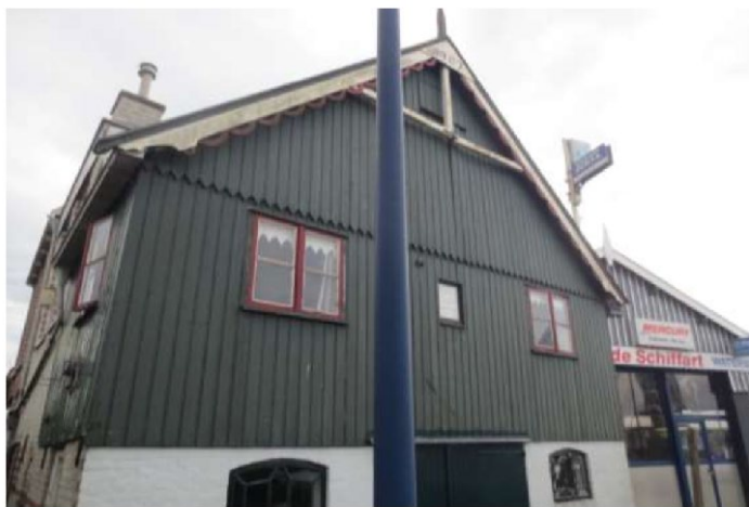
Woon-werkhuis met baksteen en getimmerde verdiepingen. Rijke gootlijsten
