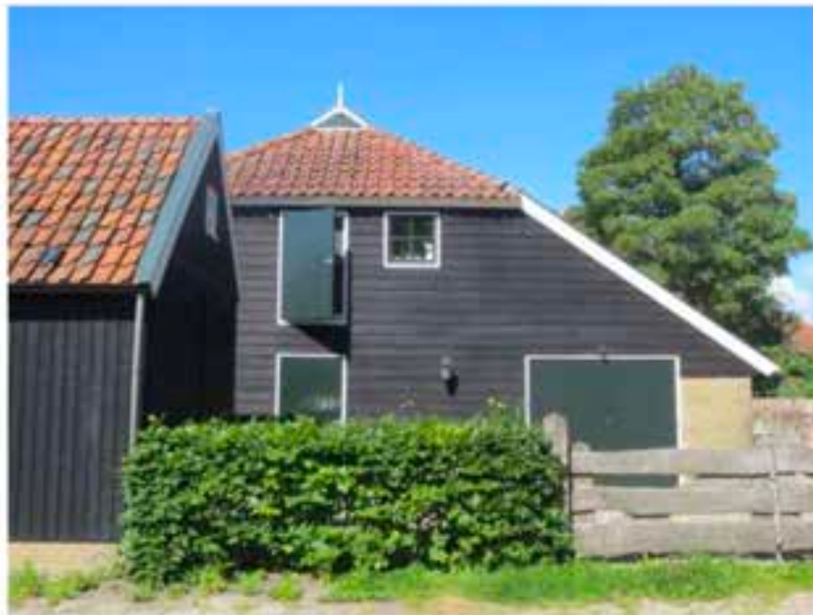
Stoere, tot woonhuis verbouwde boerderij met lage goot, grote pannenkop en wolfseind
